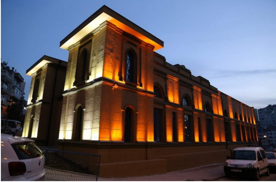
Resim 11. Bandırma Elektrik Santrali [22]
