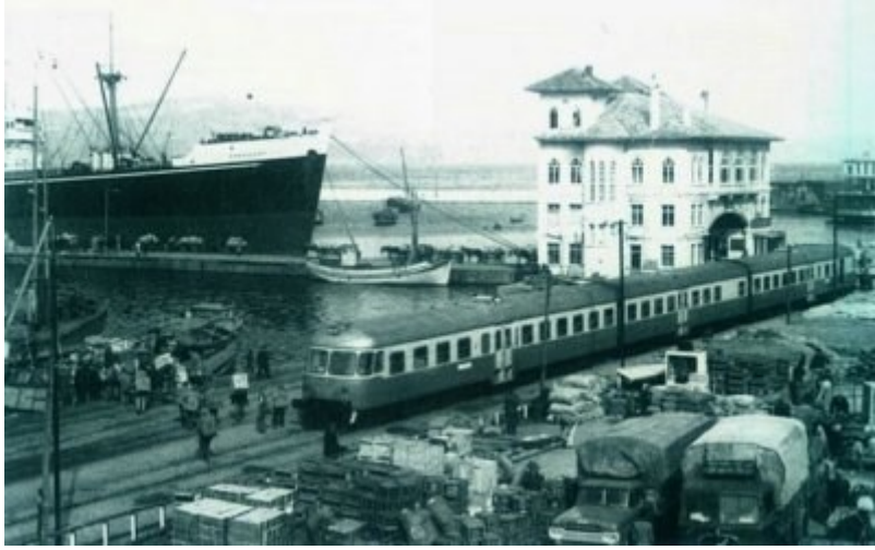
Resim 7. Bandırma Eski İskele Binası [20]
