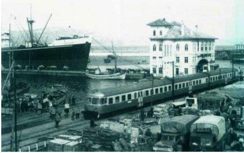
Resim 7. Bandırma Eski İskele Binası [21]
