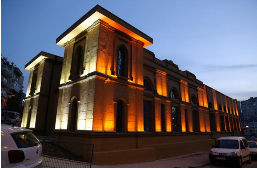
Resim 11. Bandırma Elektrik Santrali [23]
