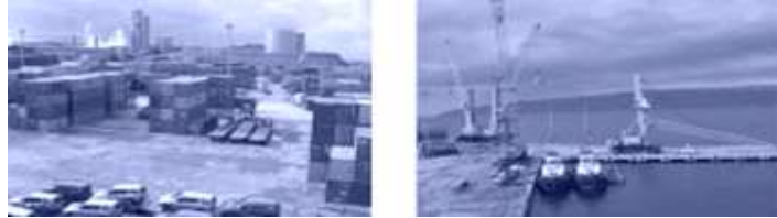
Şekil 3.15 Gemport Depolama Alanı ve Rıhtımı
